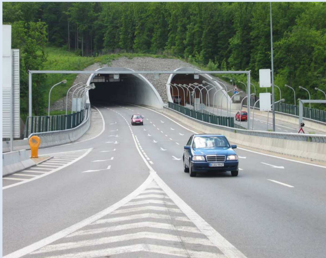
Pisárecký tunel - Brno
