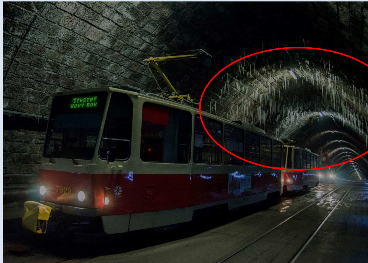
Električkový tunel pod hradom - Bratislava
