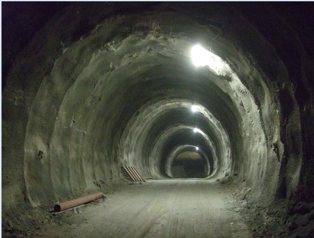
Tunel Višňové – priečne prepojenie
