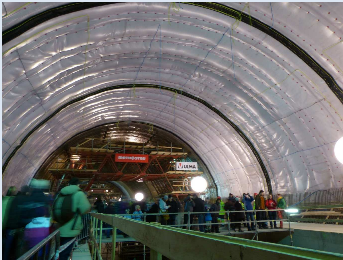
Metro Praha - trasa A - Stanica Petřiny
